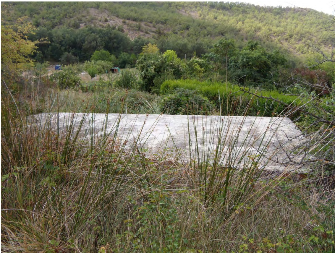
Figura nº 45. Arqueta cerrada de la captación del manantial del Borbotón en Fuentes de La Alcarria de la que parten derivaciones sin identificar.
